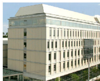
横浜市営地下鉄グリーンライン 日吉駅
